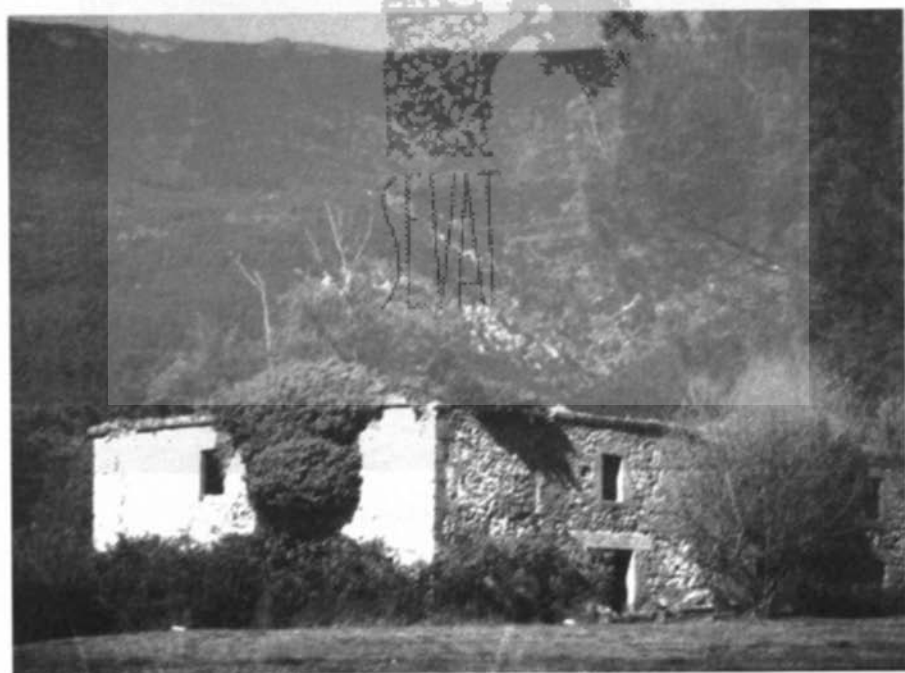
Fot. 5. Perspectiva del Molino de las Máquinas en su fachada del mediodía y en su estado actual
