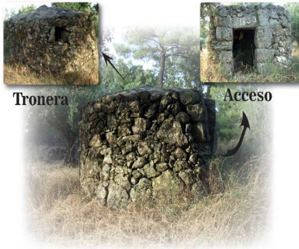
Figura 4.2.e. Pequeña fortificación circular (Nido) con piedra de granito y con techo revocado de cemento que se ha conservado en el término municipal de Casavieja.
