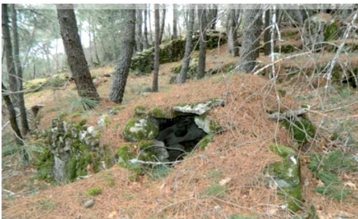
Fig. 28. Zahúrda semiderrumbada en Canto Gordo
