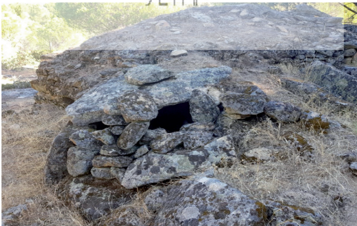
Fig. 34. Derrumbe de una zahúrda de La Adrada
