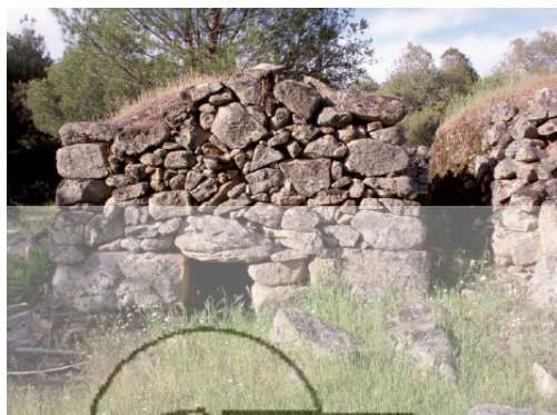
Fig. 20. Muro en talud de la zahúrda
