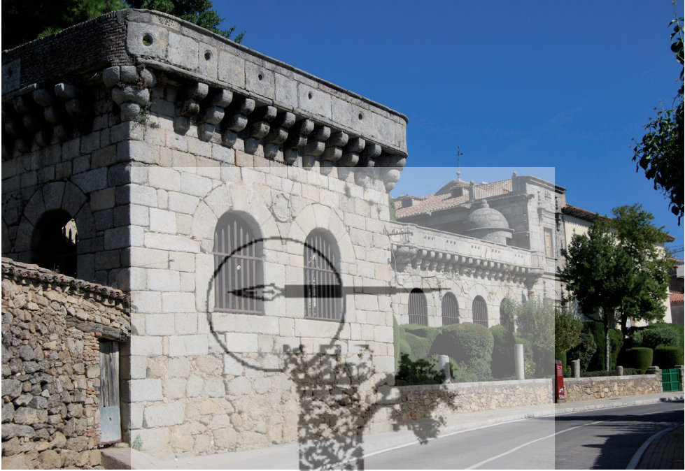
Vista del palacio de los marqueses de Villena en la villa de Cadalso de los Vidrios (2017).
