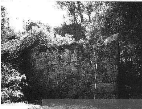
Estribo izquierdo del puente (A. Suárez)
