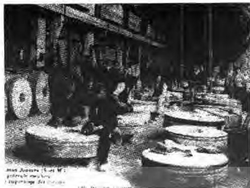
Fig. 10. Taller de preparación de las muelas de la Société Générale de la Ferté—sous Jouarre—. (Cortesía d'Amis des Moulins d'Ile de France).
