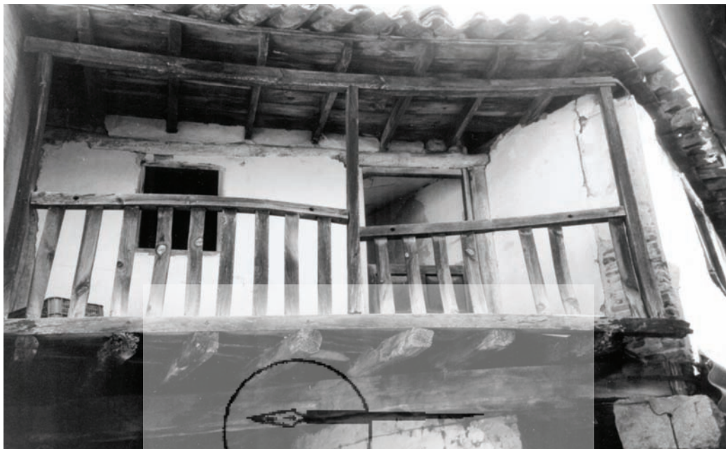
Estructura balcón de Piedralaves
