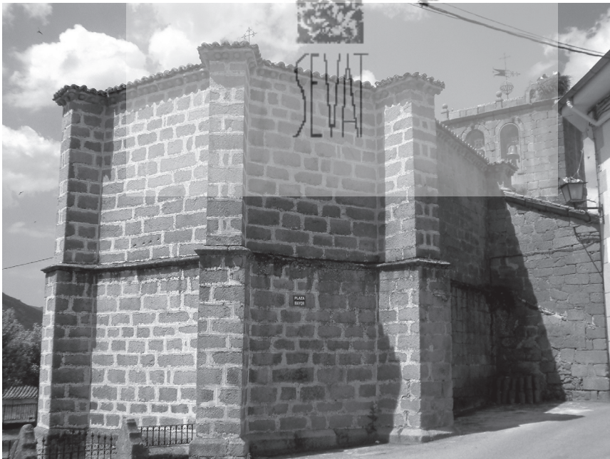
Navacepeda de Tormes. Cabecera de sillería con altos contrafuertes y cornisa con bolas en el remate
