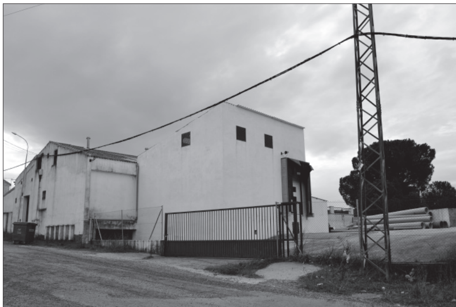
Instalaciones del Matadero municipal de La Adrada, cerrado y en desuso.
